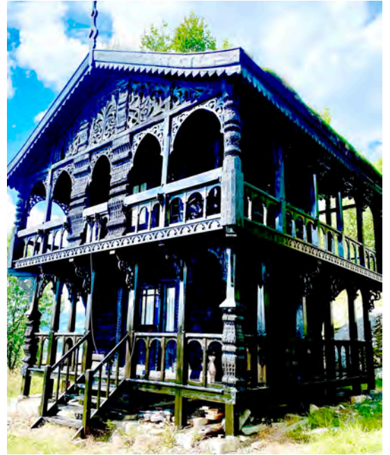
Stabburet på Botn ca 2022 etter restaurering.
